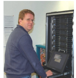
Werner Drescher im Serverraum
